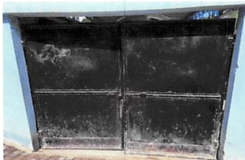
Foto 4: MANTENIMIENTO A PORTONES
