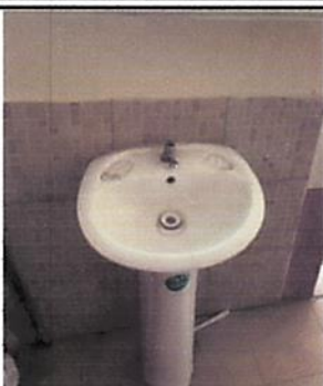
Foto 7: SERVICIOS SANITARIOS Y SUS ACCESORIOS Sustitución de lavamanos, accesorios y conexiones.
