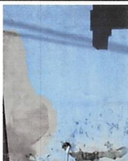
Foto 9: PINTURA EN MUROS INTERIOR Y EXTERIOR Preparación de superficie y aplicación de pintura a dos manos, en paredes interiores y exteriores del establecimiento en área de puerta exterior.
