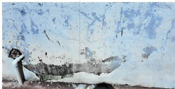
Foto 8: REPARACIÓN DE REPELLO Y CERNIDO EN PAREDES Reparación de repello y cernido en muro de mampostería con aplicación de acabado uniforme en muro exterior.
