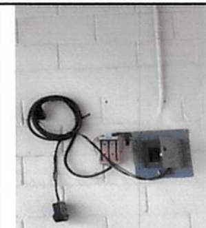
Foto 5: REPARACIÓN DE SISTEMA ELÉCTRICO
